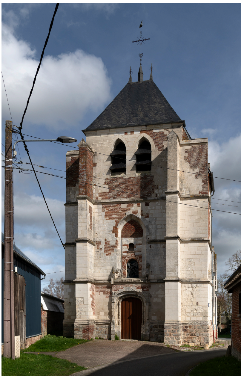
Vue générale de l'élévation occidentale du clocher.
