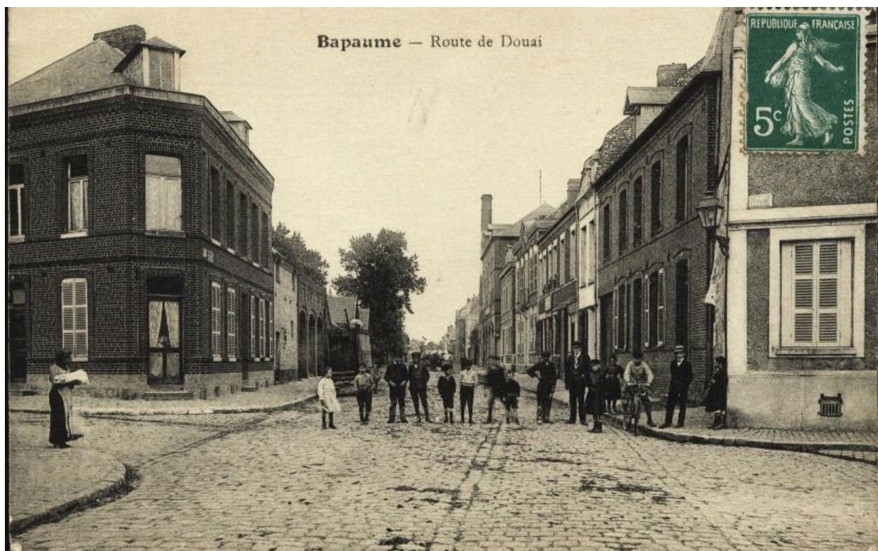
Bapaume - Route de Douai. Vue depuis la place Faidherbe ; à l'arrière plan à droite, la cheminée de la minoterie Stenne. Carte postale, avant 1914 (coll. part.).
