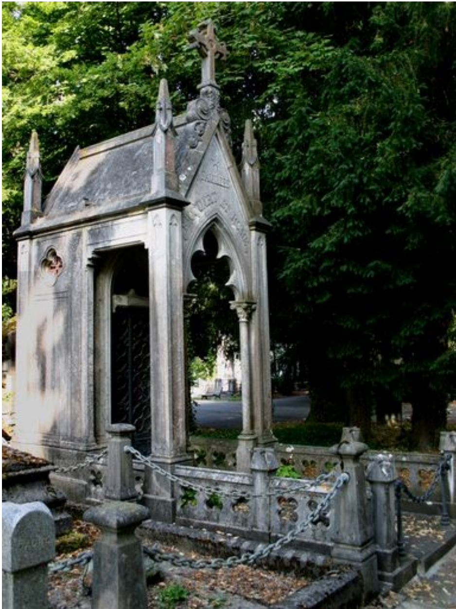
Façade latérale du tombeau-chapelle.
