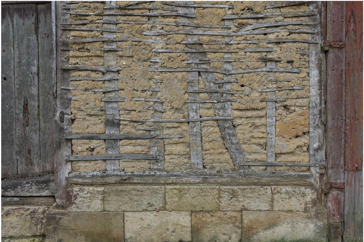
Détail de la mise en œuvre du solin et du torchis pan de bois, grange au n°41 Grande Rue.
