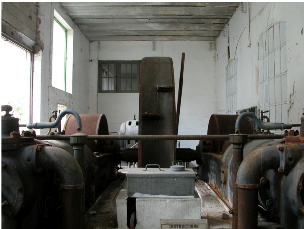
Vue générale de la machine à gaz.
