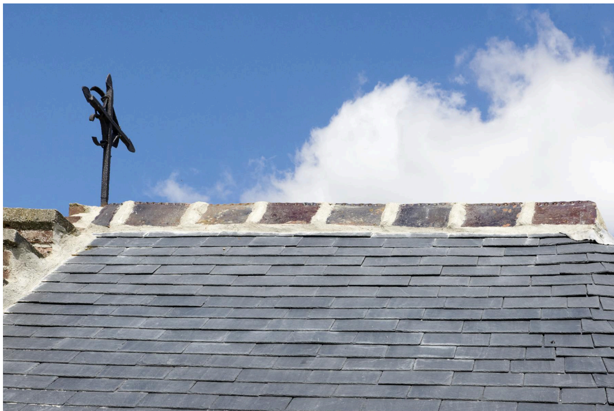
Détail de la couverture de l'édifice.
