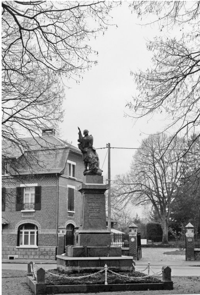
Vue générale postérieure.
