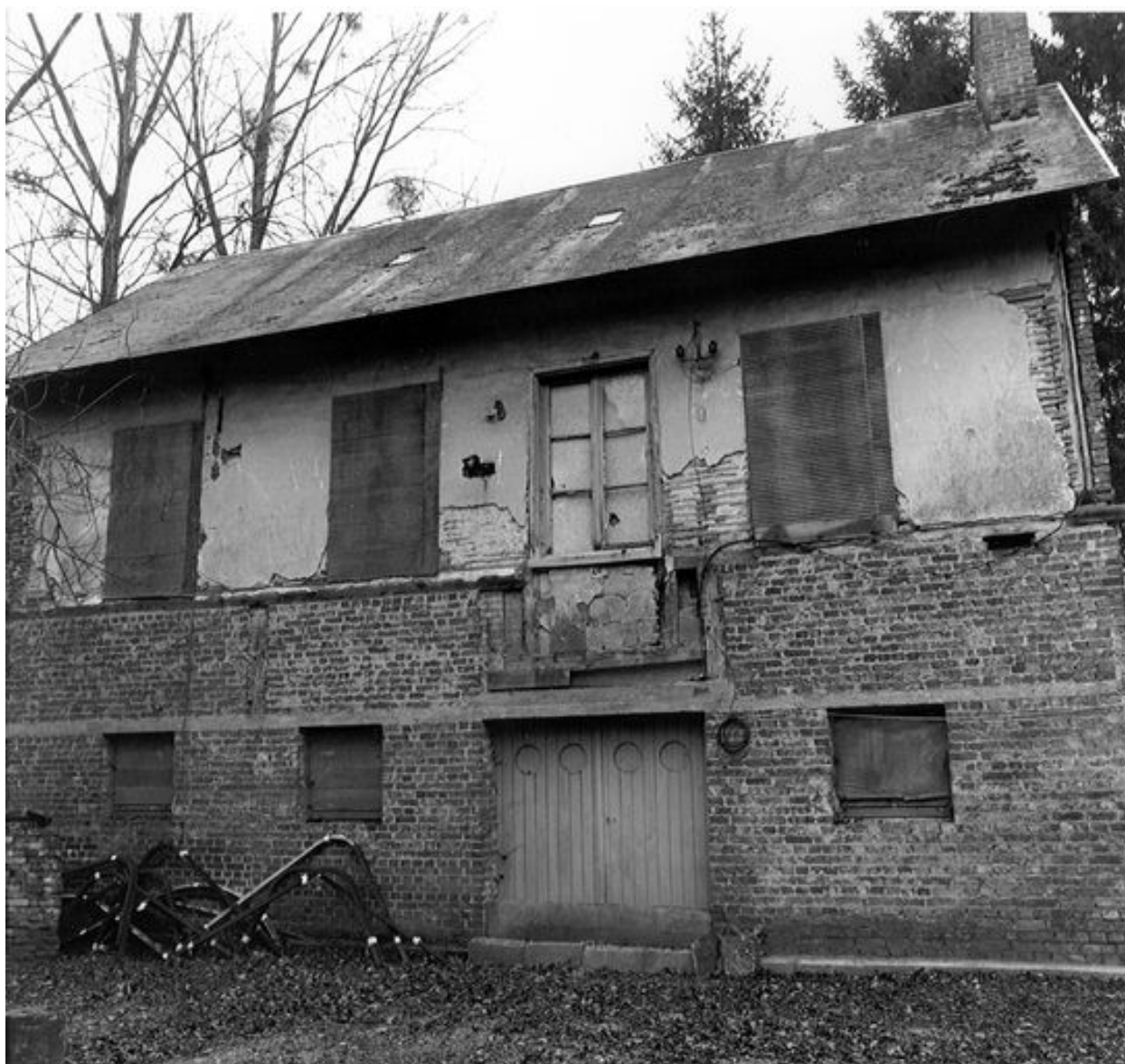
Façade sur cour du moulin.
