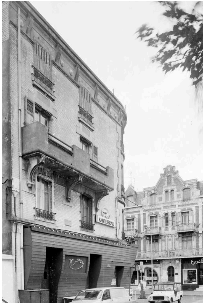
Vue d'ensemble de la façade sur la rue des Lyons en 1981.
