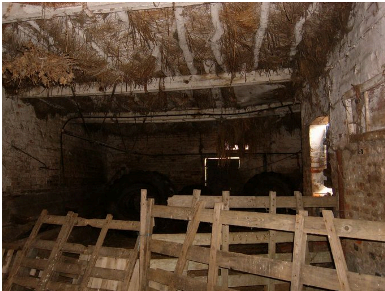
Vue intérieure des étables.
