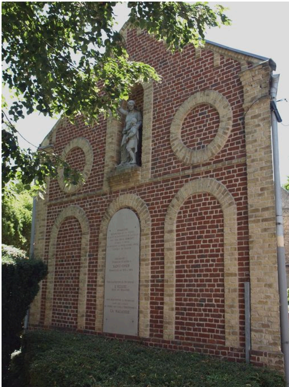
Vue générale de situation
