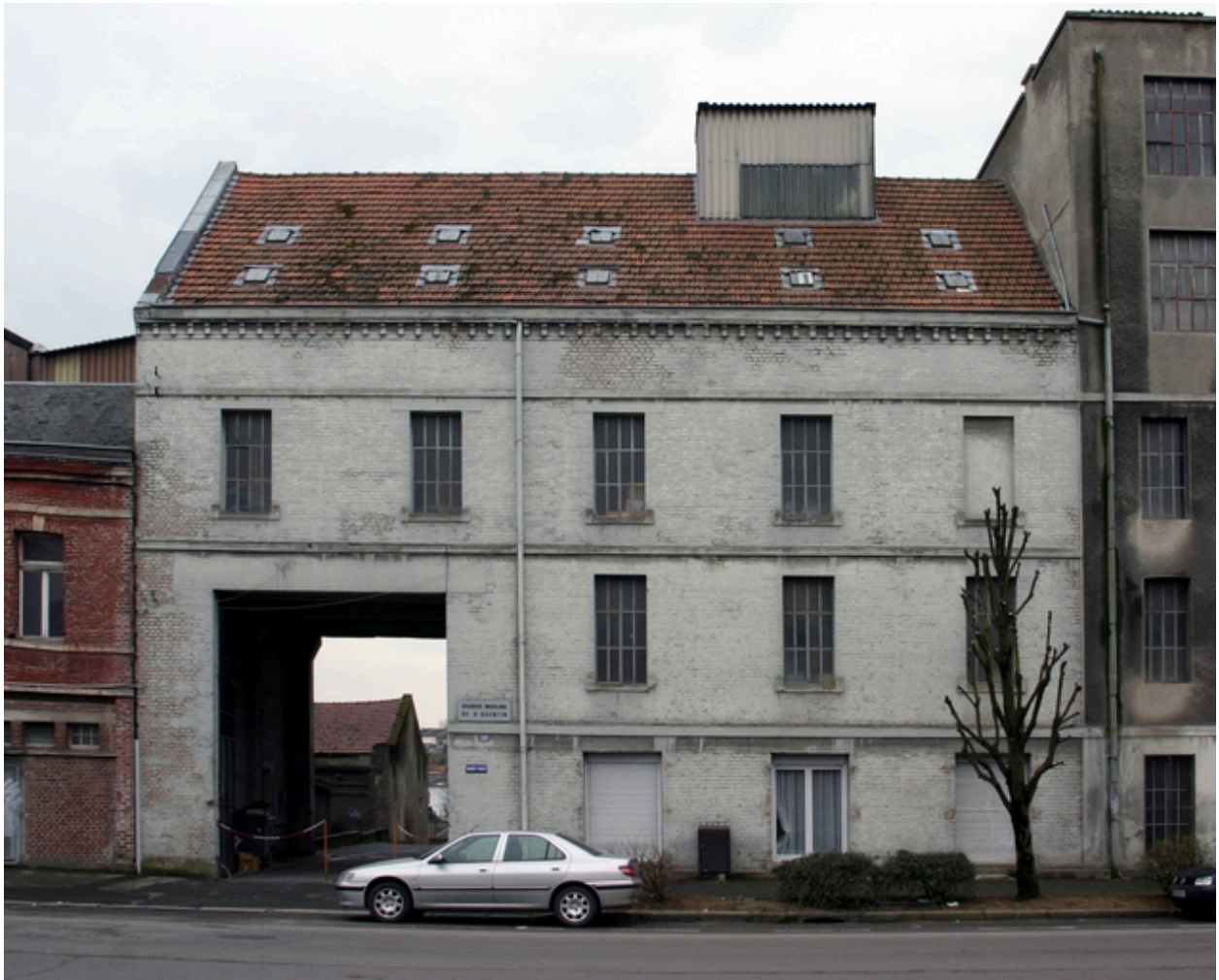
Façade antérieure de l'ancienne minoterie.
