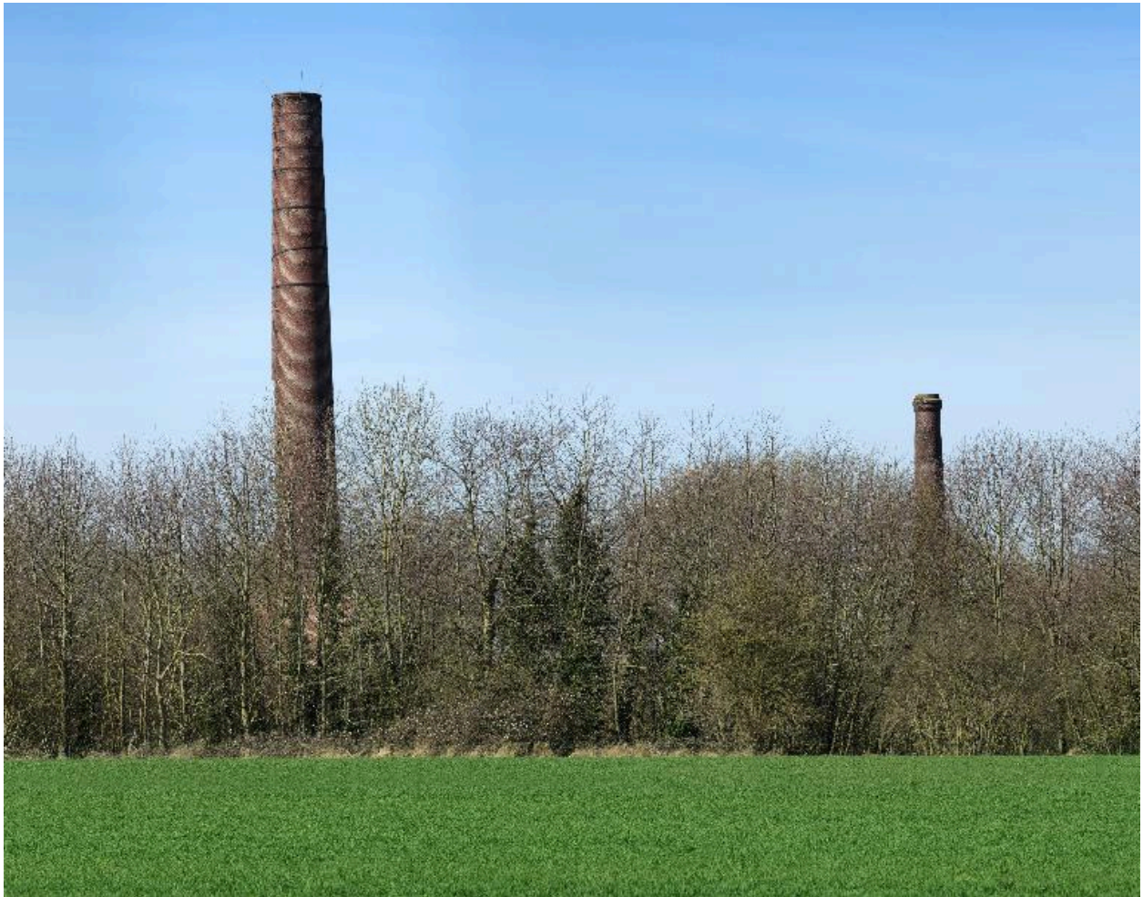
Cheminée de l'usine en ruine.
