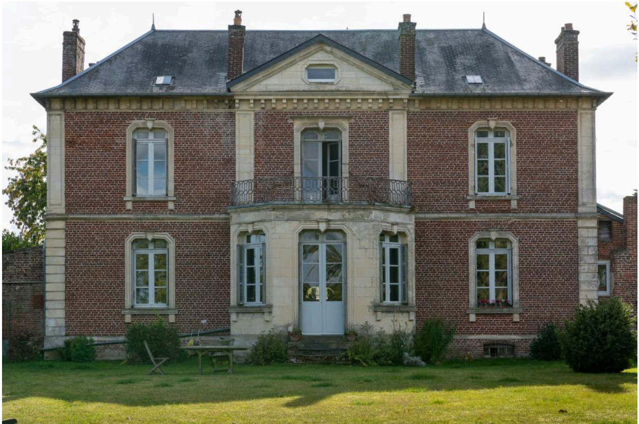
Vue générale du logis depuis le nord.
