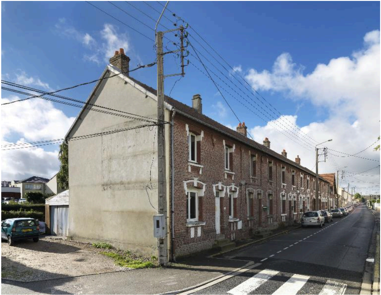
Vue générale, depuis le nord.
