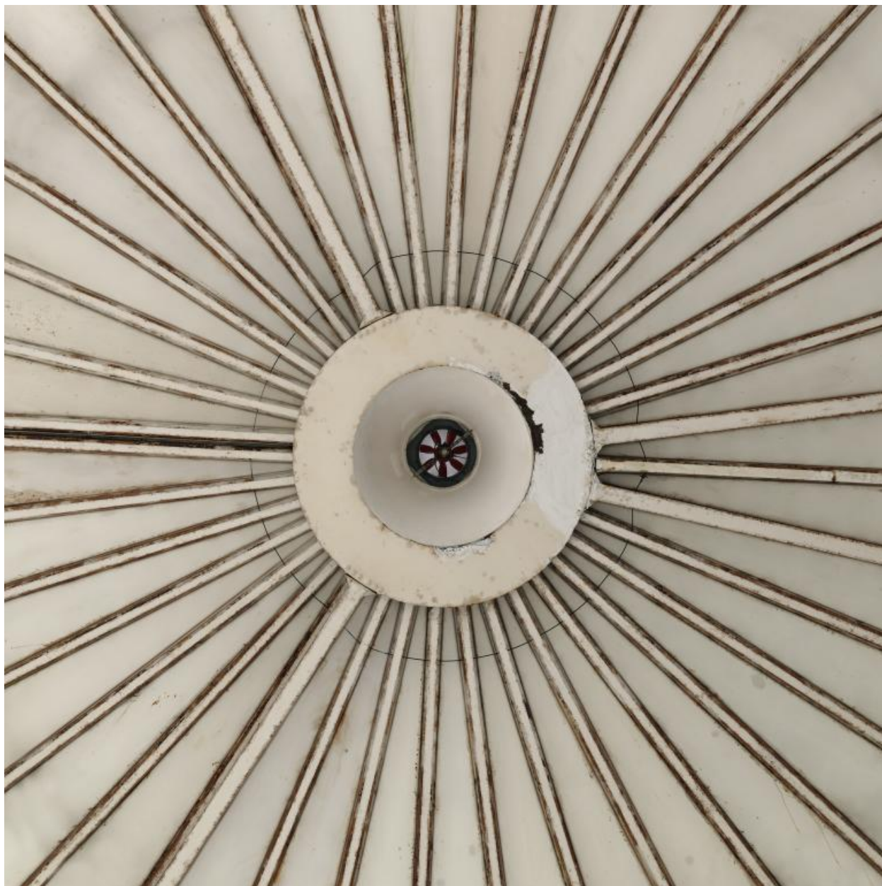
Vue intérieure de la partie supérieure du dôme.
