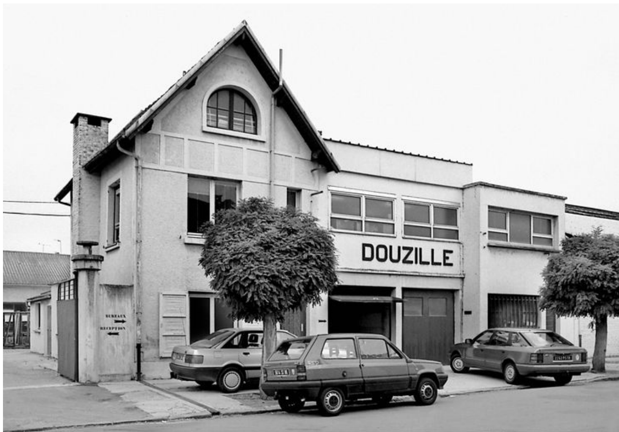
Bureau, conciergerie : élévation antérieure.
