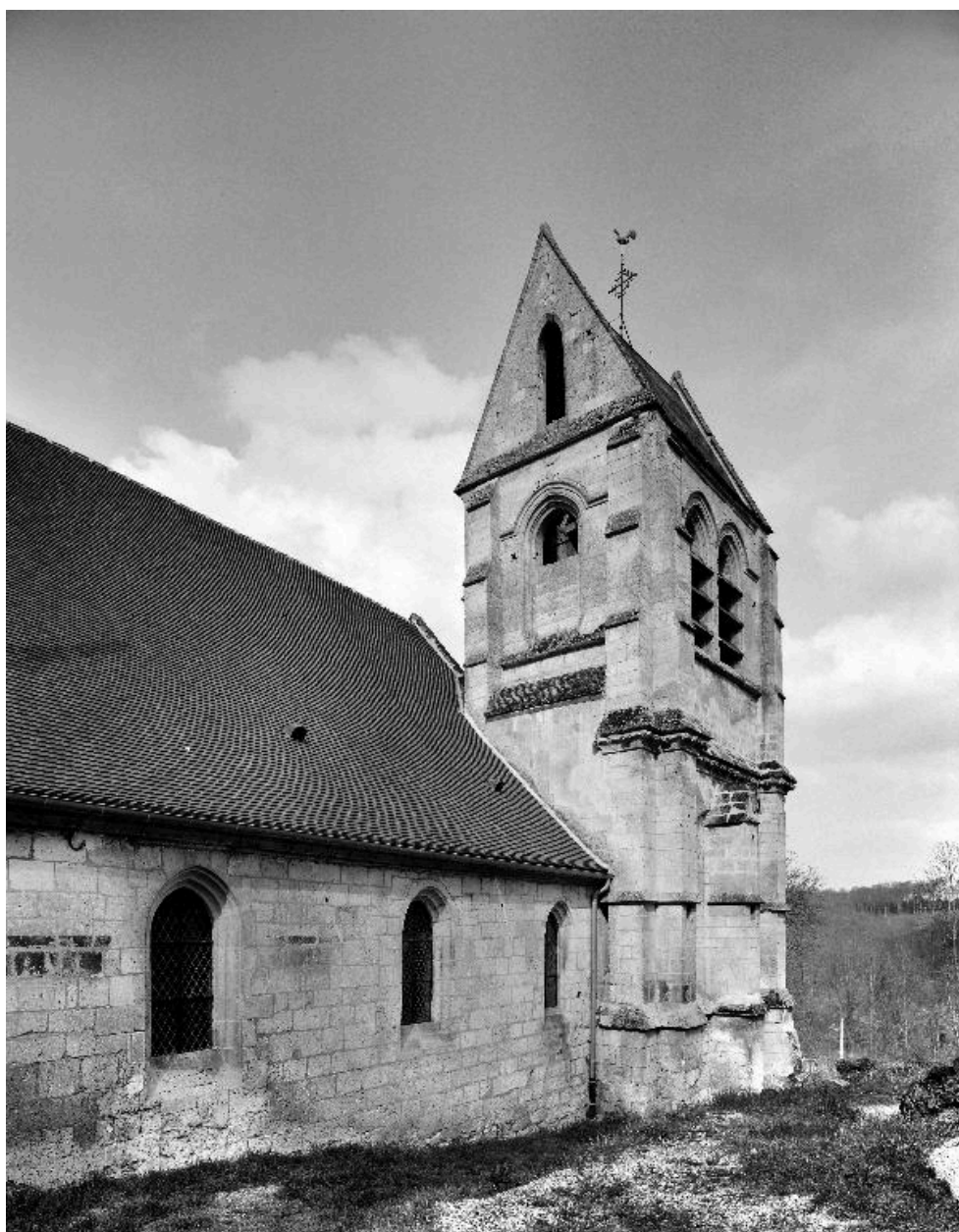
Vue du clocher et de l'élévation sud de l'église.
