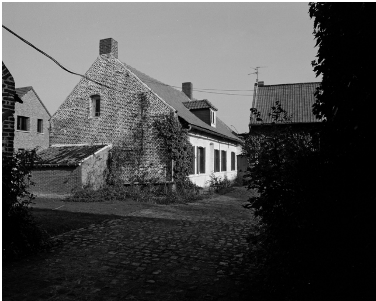
Ferme située très en retrait de la rue (dispositif du 17e siècle ?), rue Lelier.
