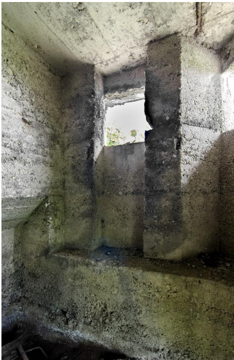
Vue intérieur du poste d'observation
