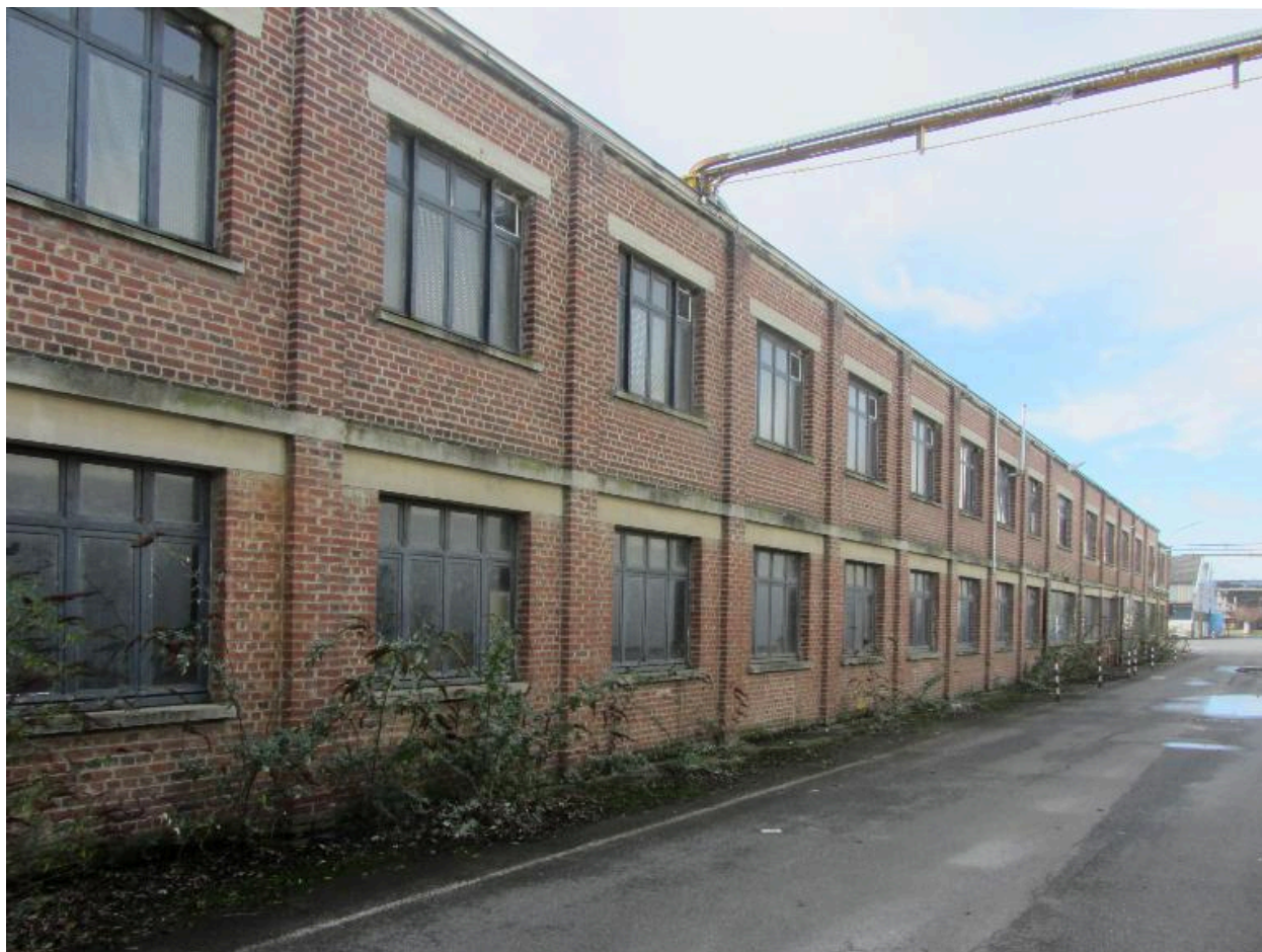
Façade longitudinale de l'atelier de maintenance.
