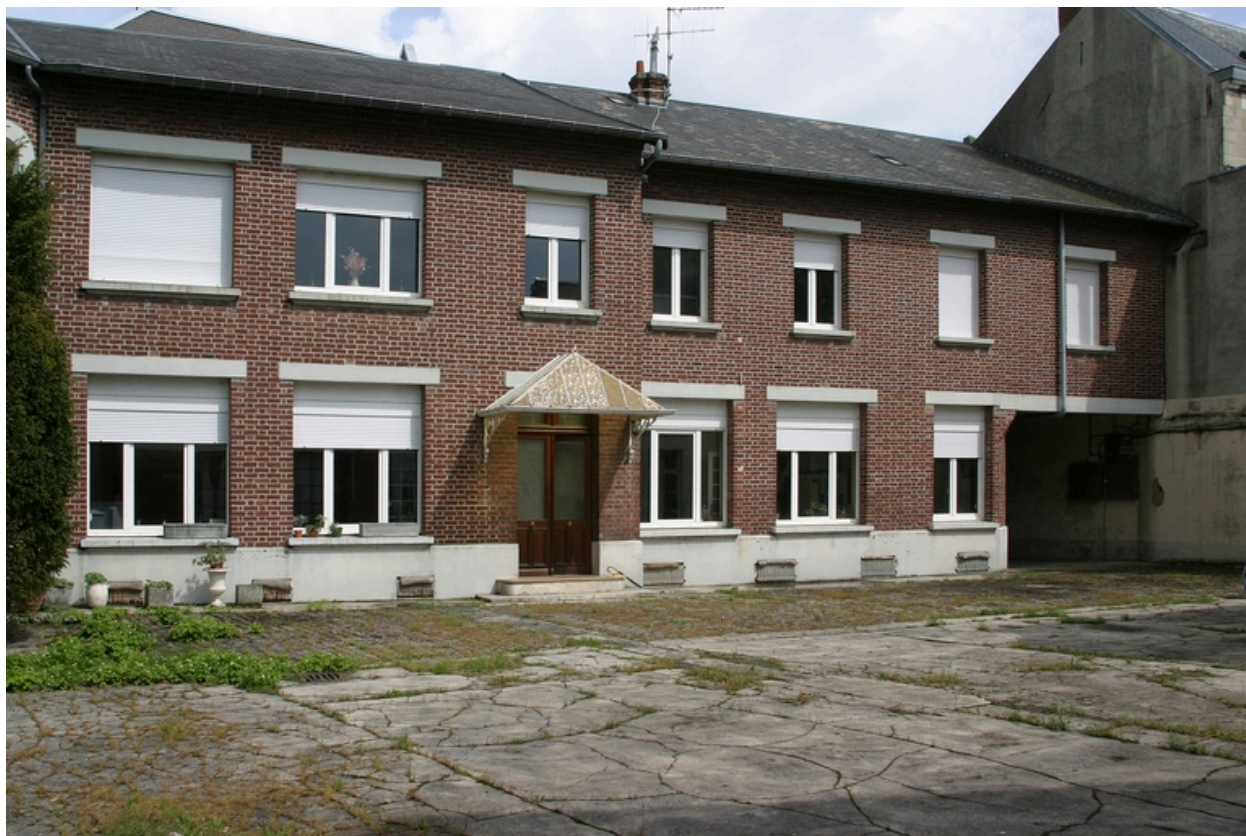
Façade antérieure du logement patronal : à droite, le porche donnant accès à la rue Etienne-Dolet.
