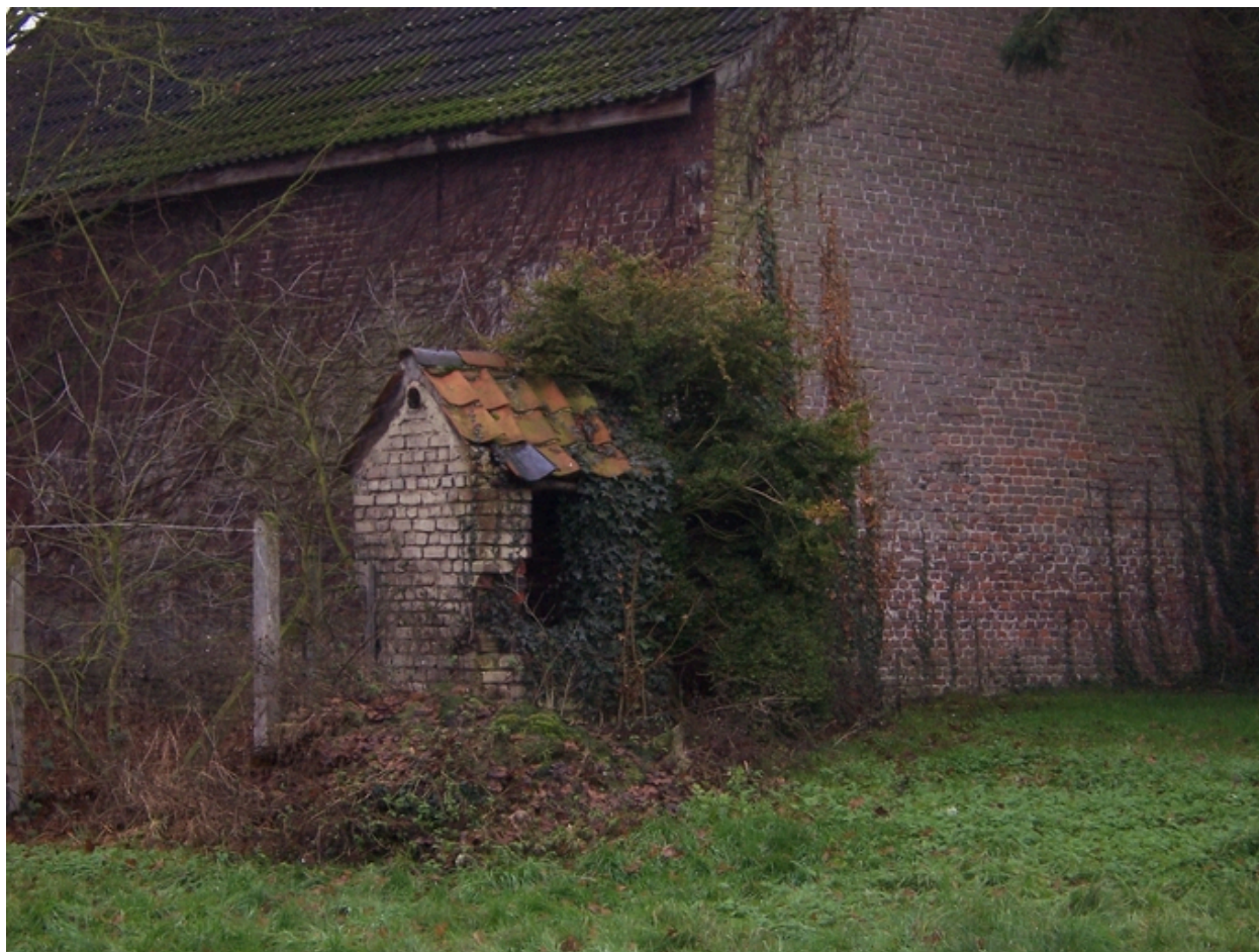
Vue générale du puits I.
