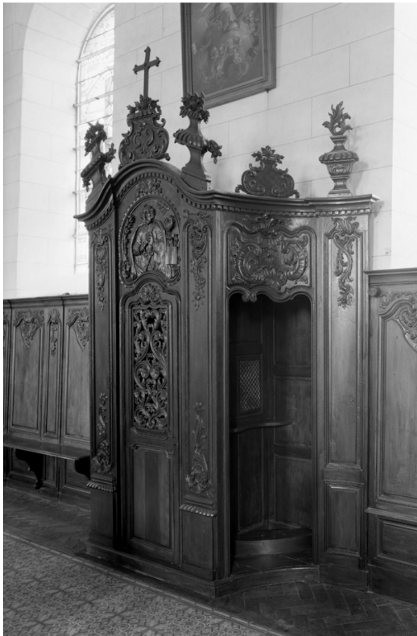
Vue du confessionnal du bas côté nord.
