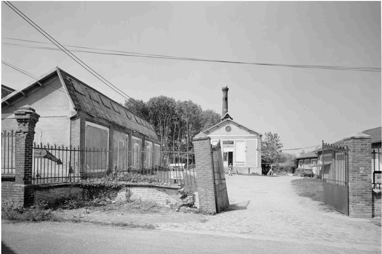
Entrée principale, chaufferie et atelier de fabrication.
