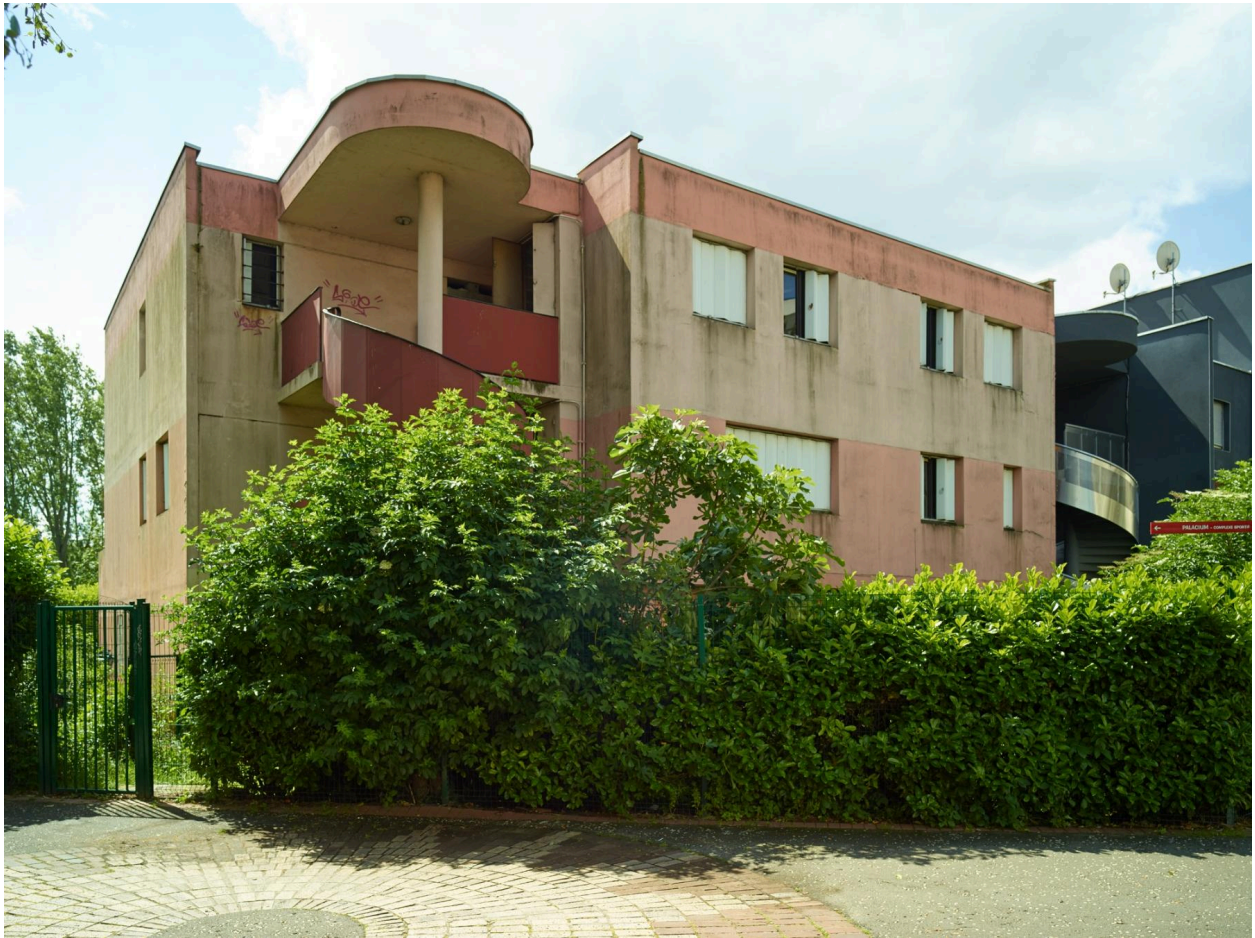
Les logements de fonction : façade sur le chemin des Bergères, au nord.
