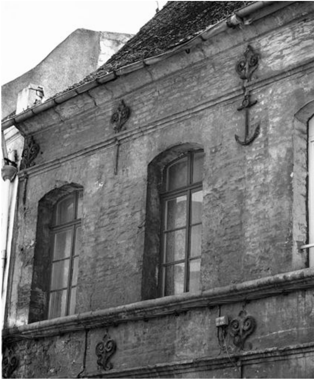
Maison n° 10, vue partielle : étage carré, modénature, ancrage (état en 2001).
