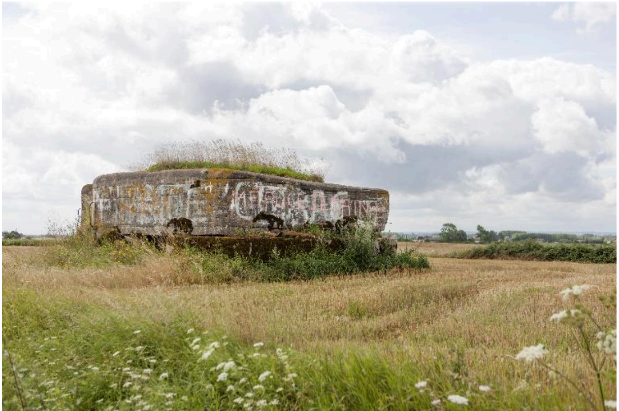
Vue générale, vers le sud
