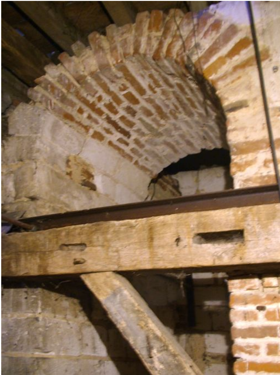
Baie sud de l'ancien clocher-mur.
