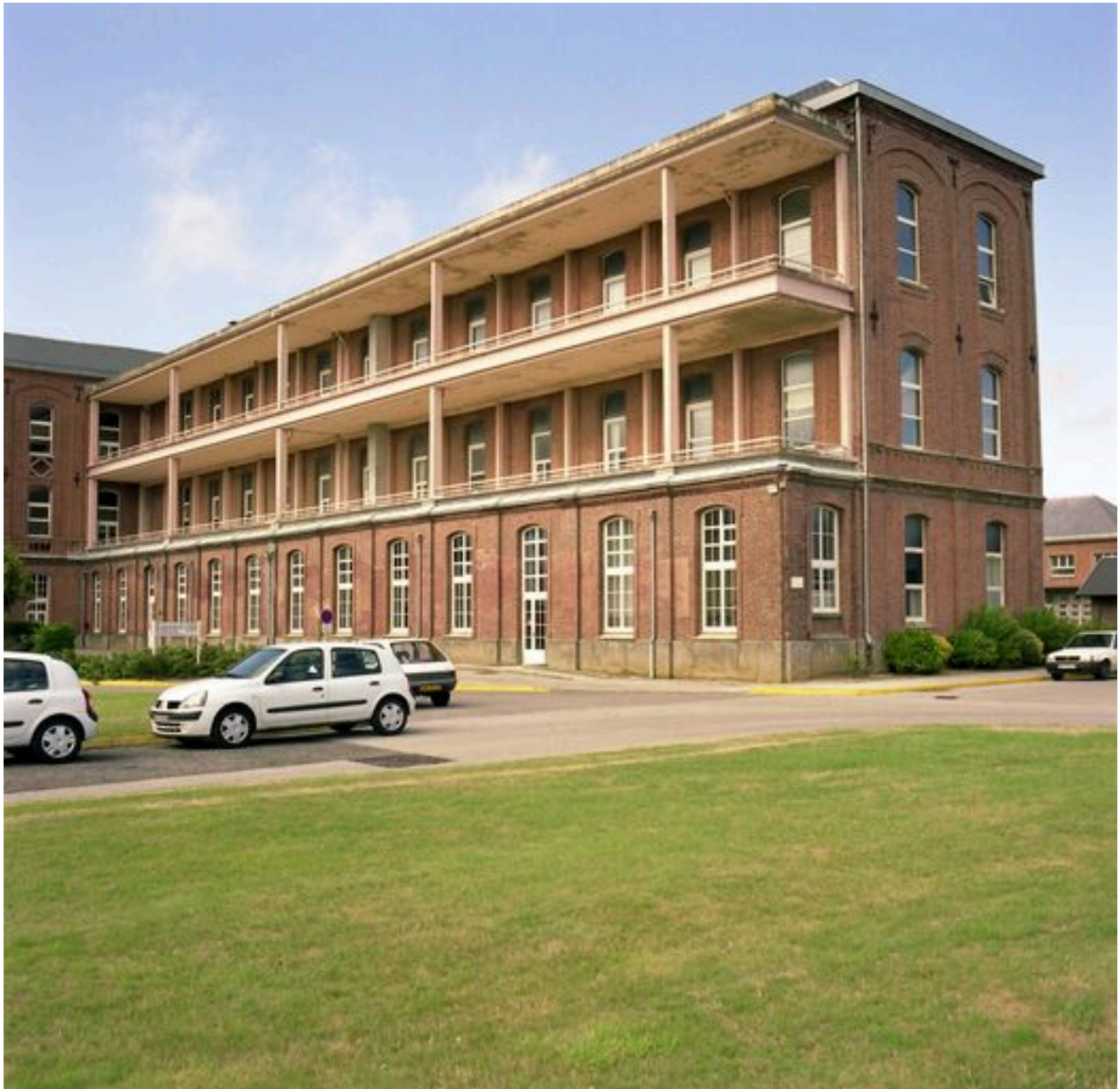
Corps de logis principal, élévation sud de l'extrémité est du bâtiment septentrional, vue de trois-quarts droit.
