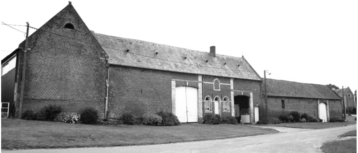
Vue générale depuis le nord.
