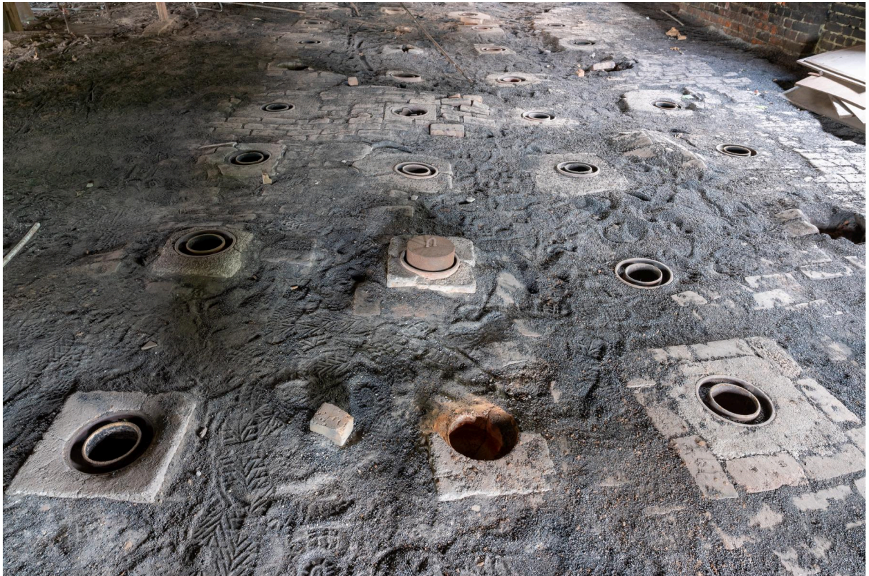
Couvrement du four Hoffmann. Au sol les trappes d'alimentation en poudre de charbon.
