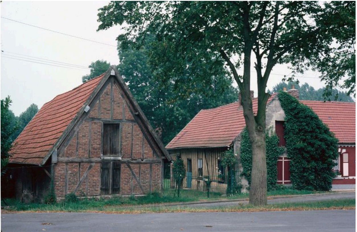
Maison et grange en pan de bois hourdé en briques, rue de la Place.
