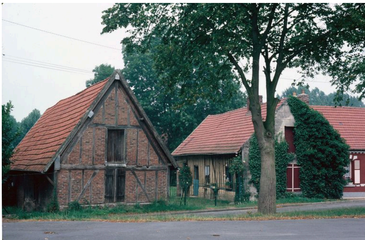
Maison et grange en pan de bois hourdé en briques, rue de la Place.
