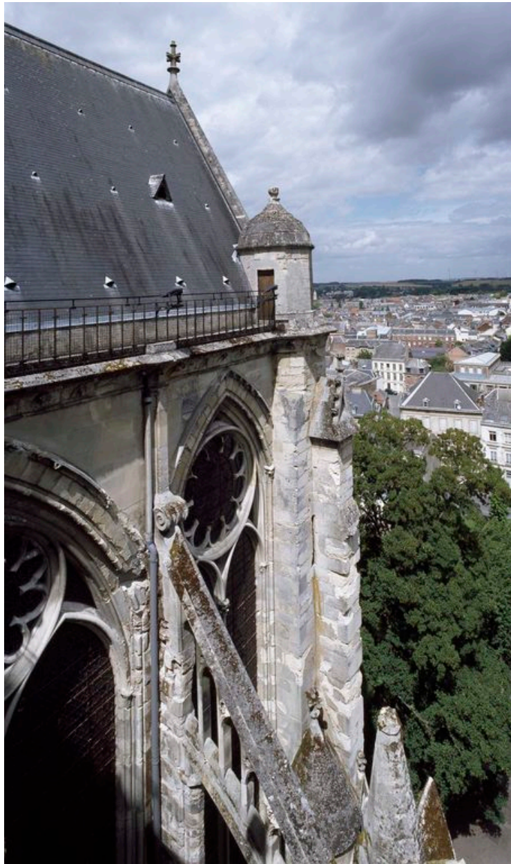
Vue partielle du bras nord du petit transept.
