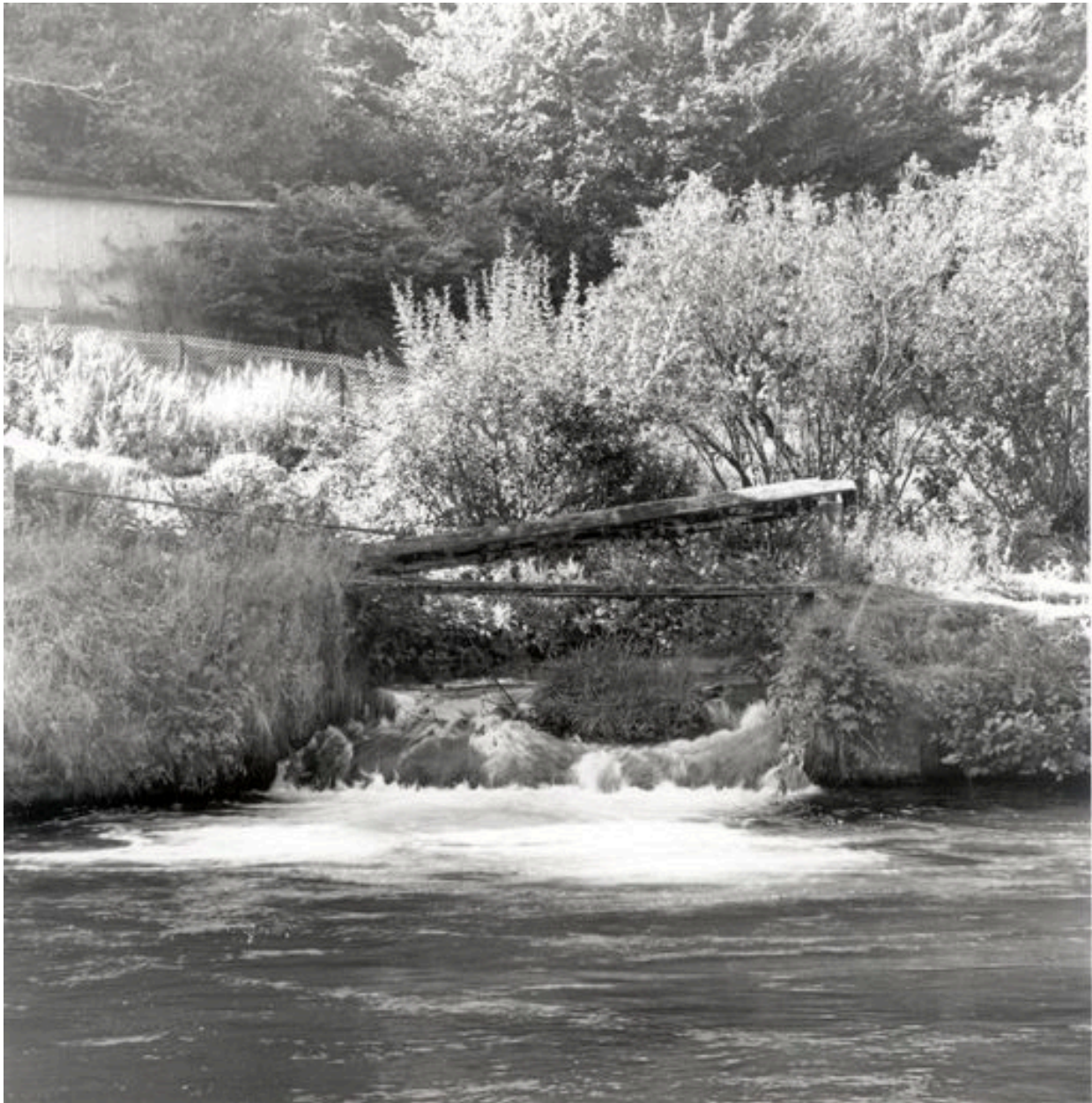
Les vestiges du vannage de décharge.
