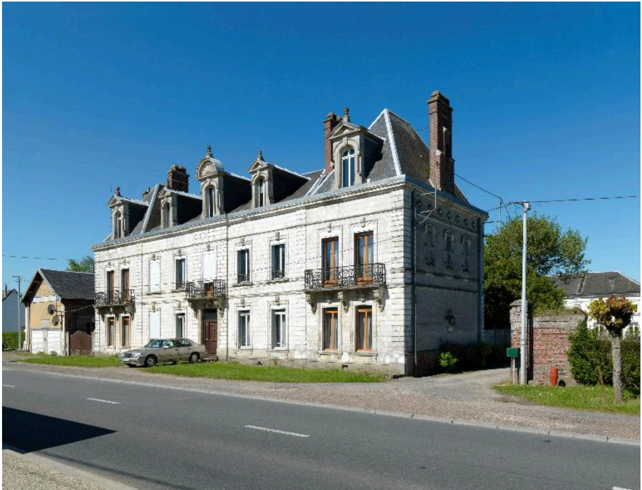
La façade sur rue, vue de trois-quarts.
