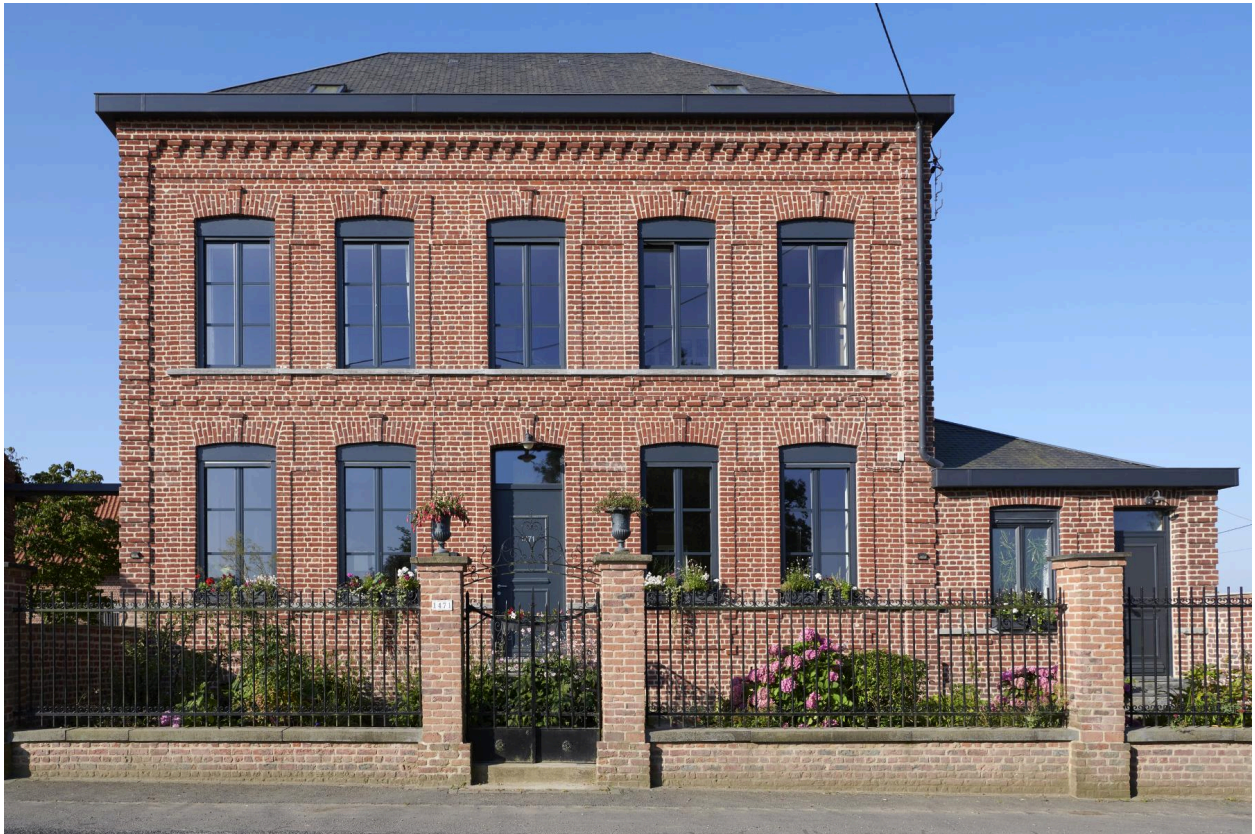
Façade sur rue du logis principal.
