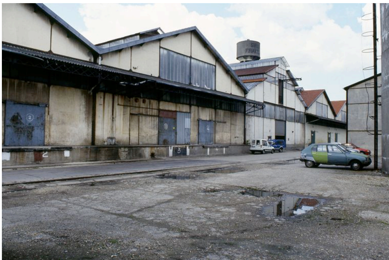
Quai de chargement le long de la feutrierie.
