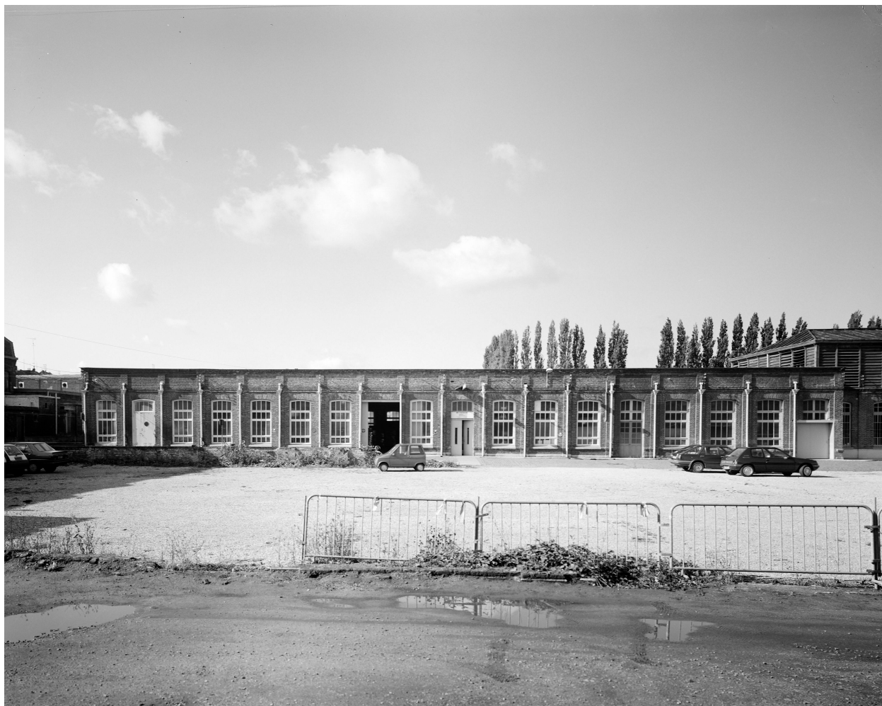
Atelier de fabrication. Vue prise vers l'ouest.
