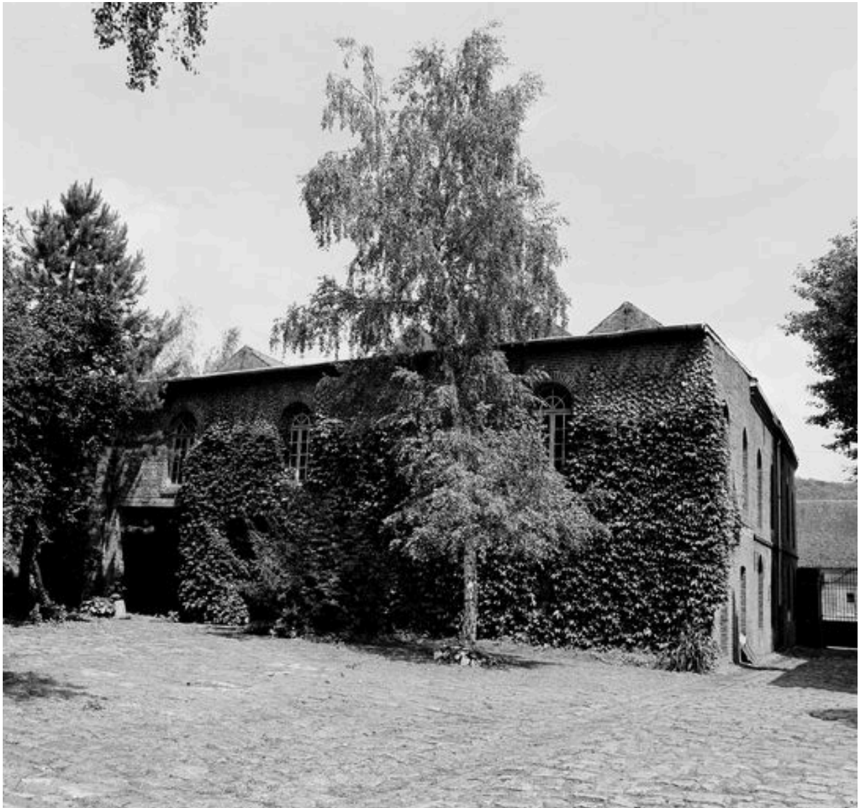
Atelier de fabrication : façade postérieure.
