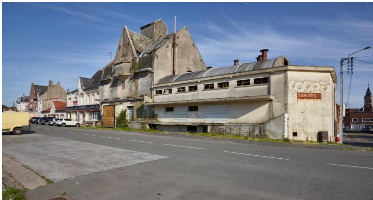
Vue générale côté sud.
