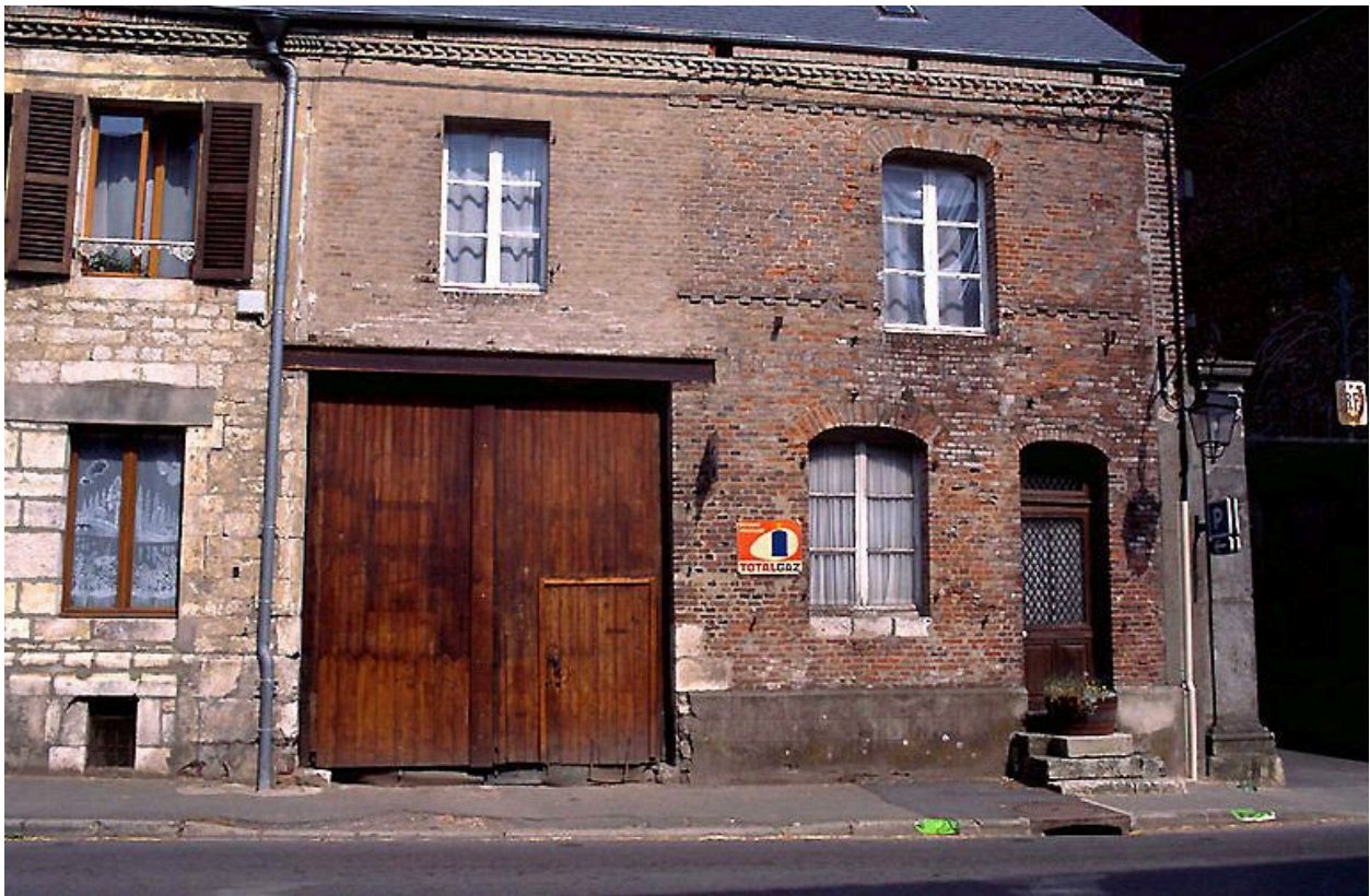
Vue de l'élévation sur rue du n°6.
