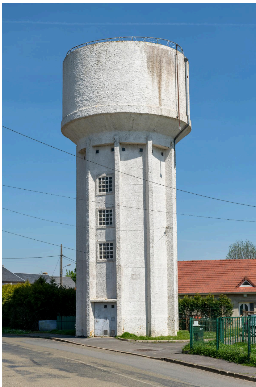
Château d'eau, rue de la Grand Cour.
