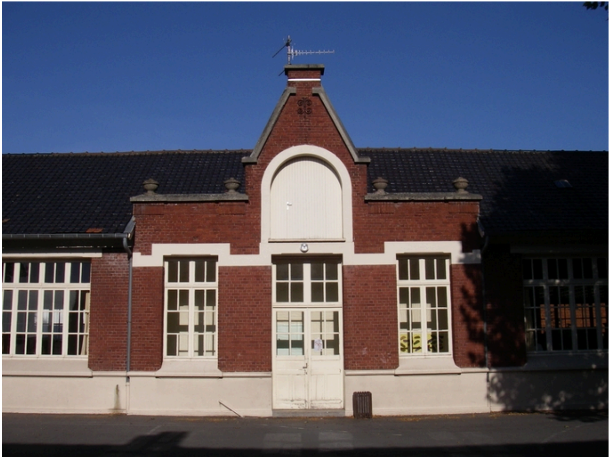
Groupe scolaire, salles de classes des garçons, détail de la porte et de la lucarne-pignon.
