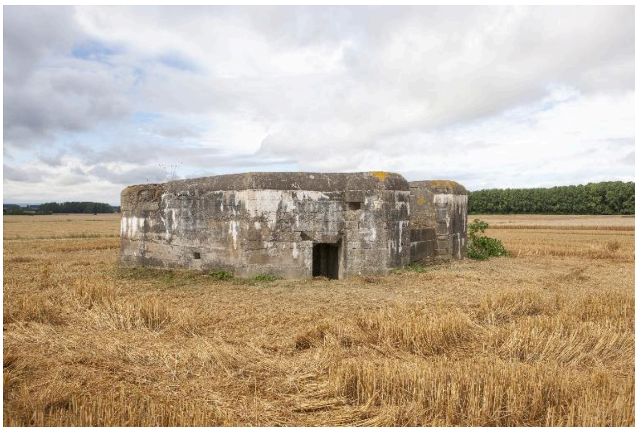
Vue générale vers l'ouest, entrée sud-est.
