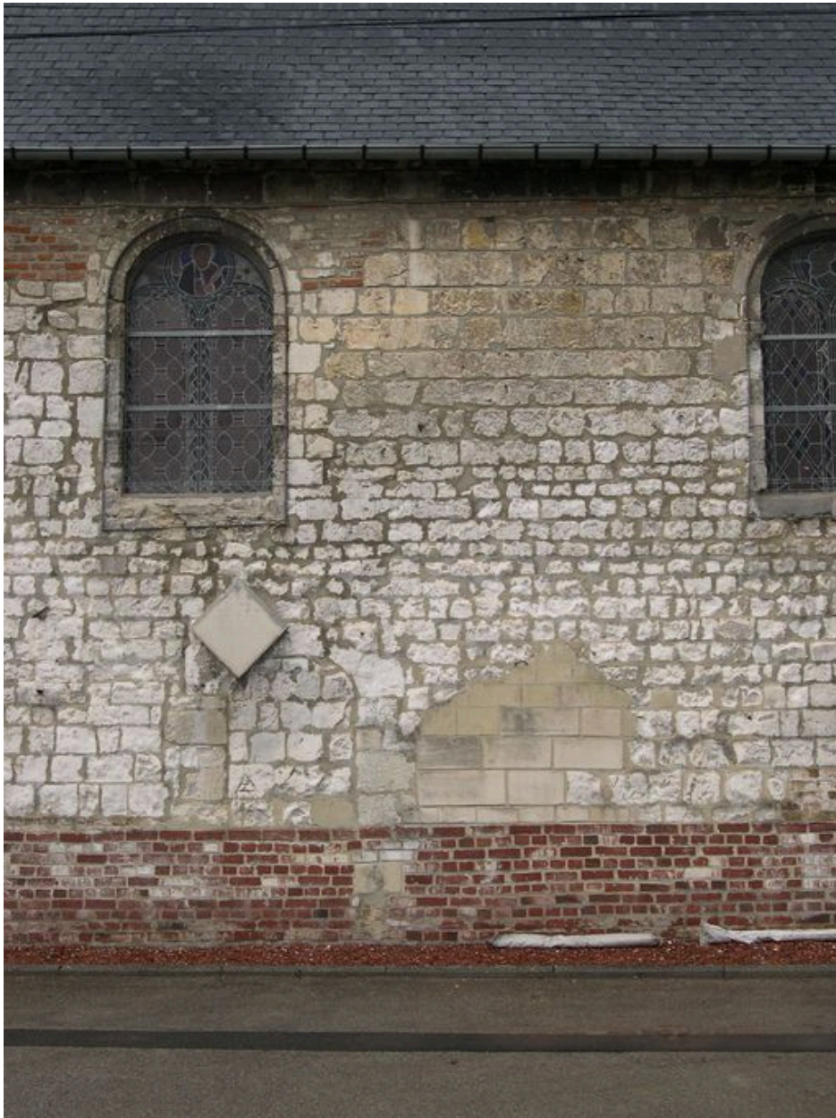
Détail du mur sud.
