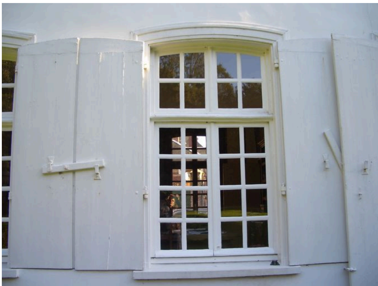
Vue détaillée des contrevents.
