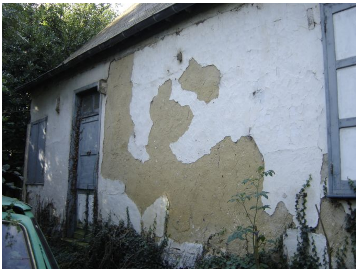
Détail des deux dernières travées.
