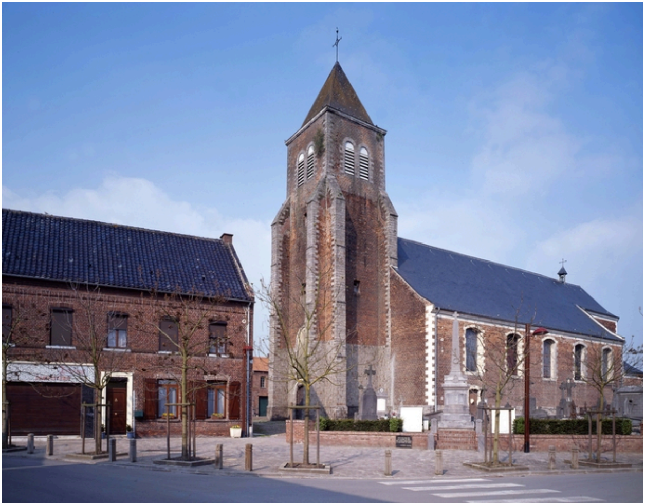
Vue générale depuis la rue de l'Eglise.
