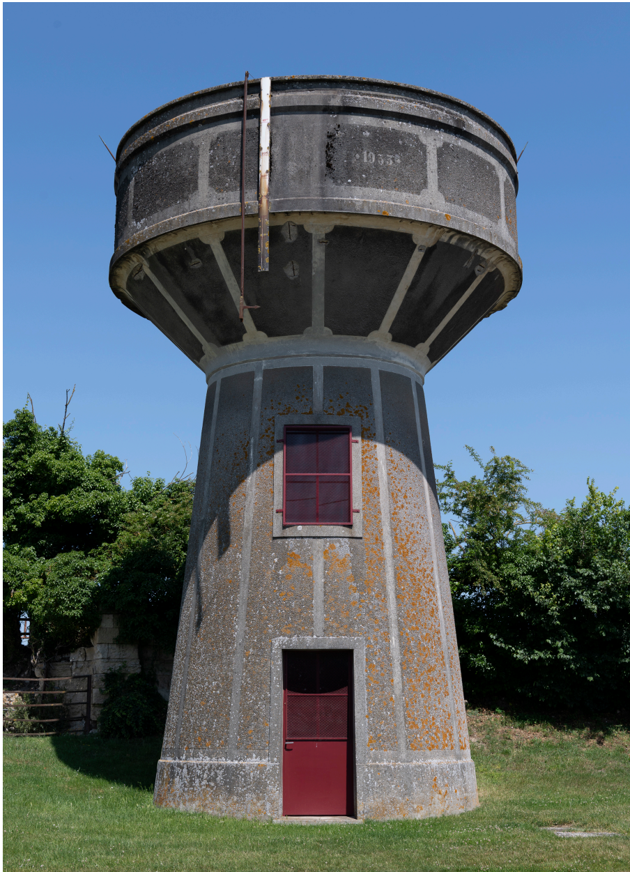
Château d'eau, rue Neuve, vue depuis le sud.
